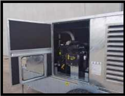
COFANATURA INSONORIZZATA 70dB (A) SOUNDPROOFED CANOPY 70dB (A)
