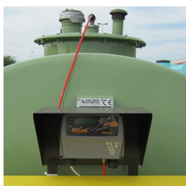
OCIO installato su Tank Fuel
