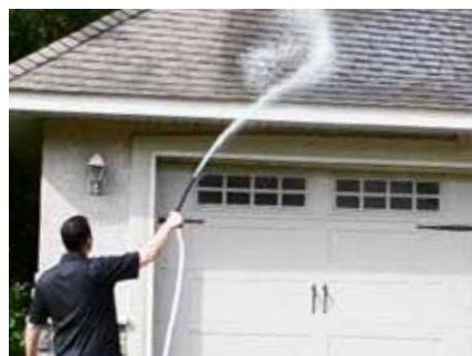
Soft wash Lavaggio facciate
